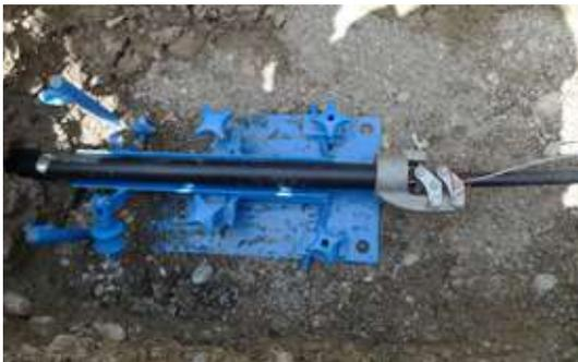
Mit dieser Verfahrenstechnik lassen sich ohne durchgehen- des Aufgrabens Verkehrswege kreuzen und Hausanschlüsse herstellen. Zuvor werden eine Start- und eine Zielgrube ausgehoben. In Einzelfällen kann auch direkt aus dem Kellerbereich gestartet werden. Das erspart eine Startgrube bzw. ein Kopfloch, und das Gelände bleibt unberührt.
