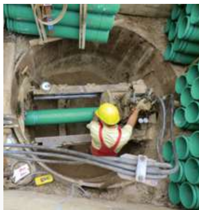
Grabenloser Einbau im Pilotrohr-Vortrieb
