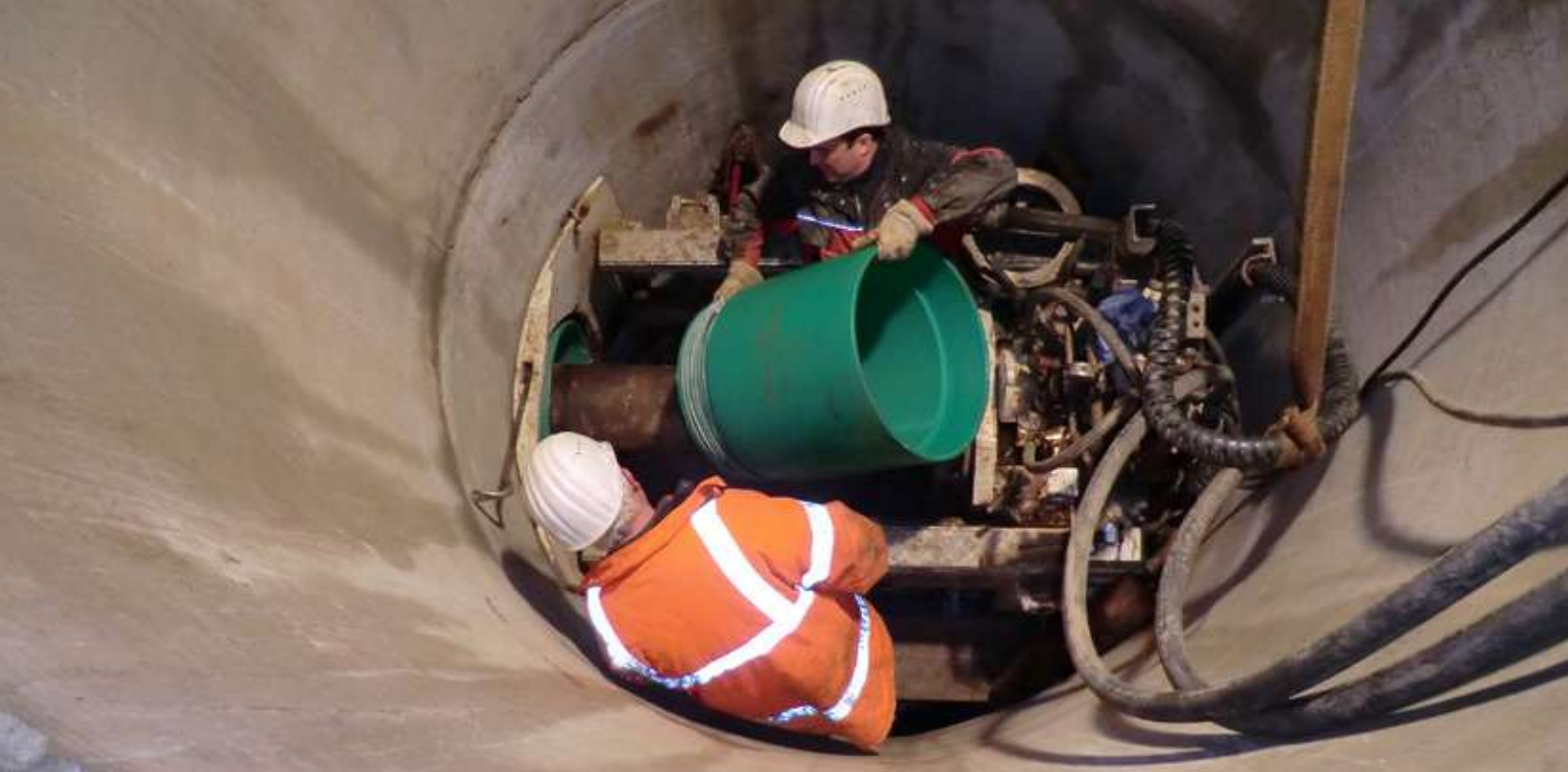
Rohrvortrieb DN/ OD 560 aus Pressschacht DN 2000
