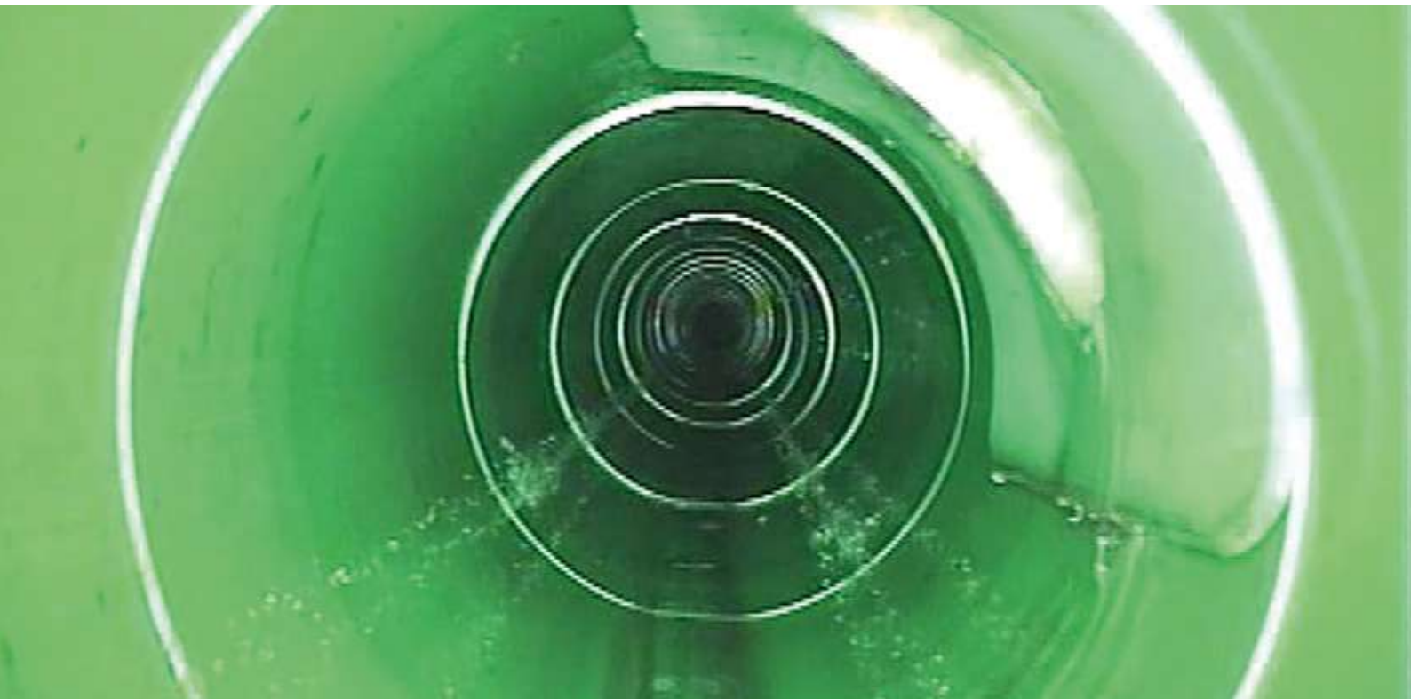
Einschweißsattel zur grabenlosen Anbindung von Anschlussleitungen
