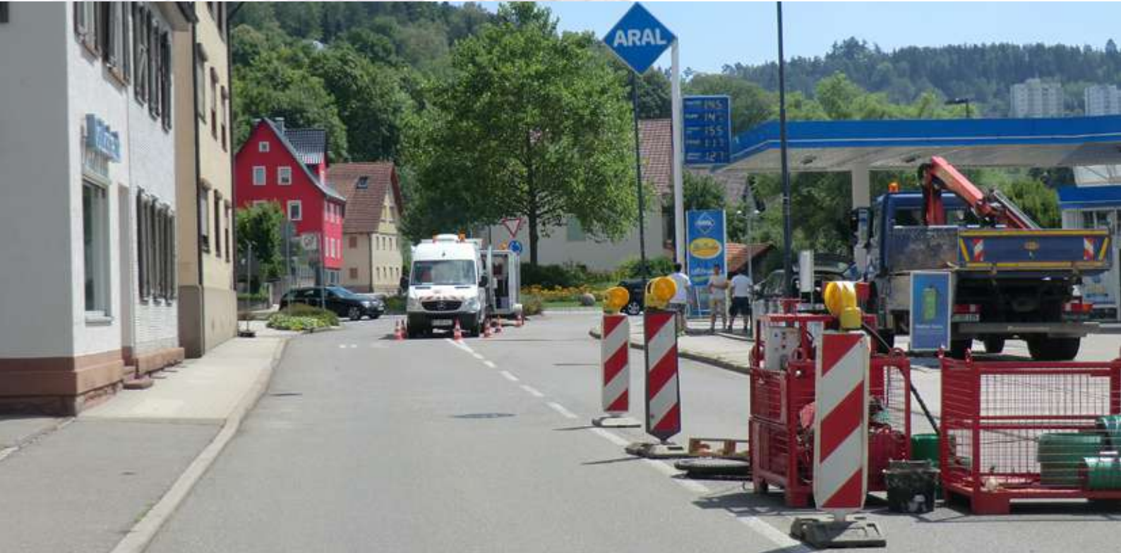
Sanierung Schacht zu Schacht
