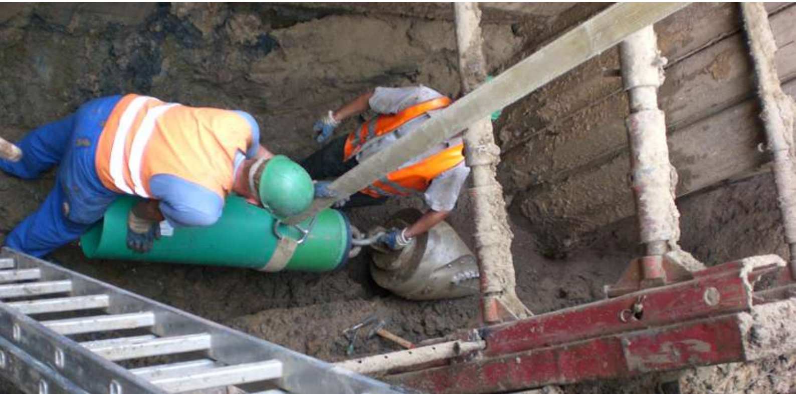
Einzelrohreinzug Spülbohrverfahren
