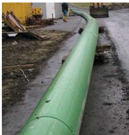
Vortriebsrohre DN/OD 225 in geschlitzter Ausführung
