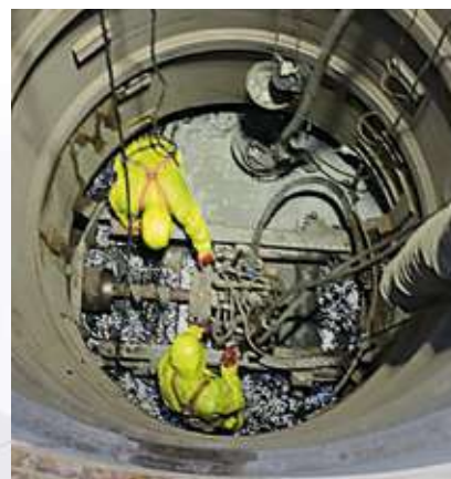
Bohr-Pipe-Verfahren zum grabenlosen Einbau von gelochten Vortriebsrohren
